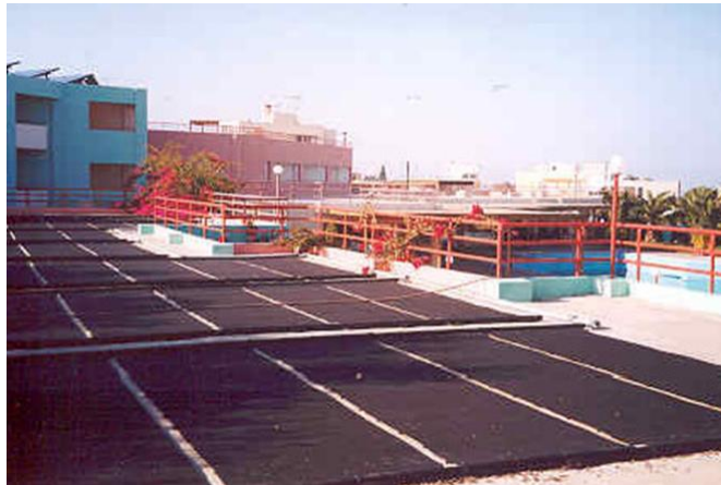
Εικόνα 1.9 : Ηλιακοί συλλέκτες χωρίς κάλυμμα για τη θέρμανση πισινών
